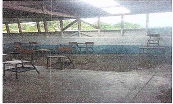
Foto 2: MEJORAMIENTO DE PAREDES
