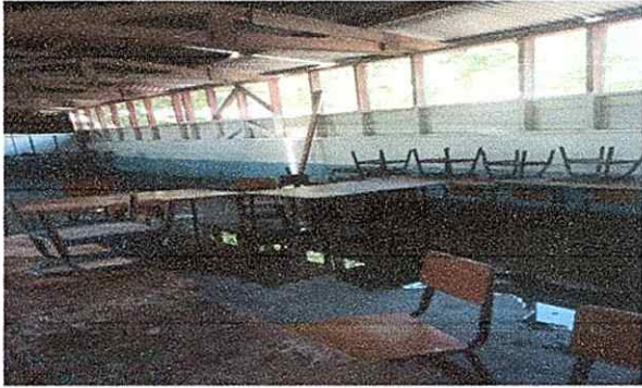
Foto1: MEJORAMIENTO DE PISO
